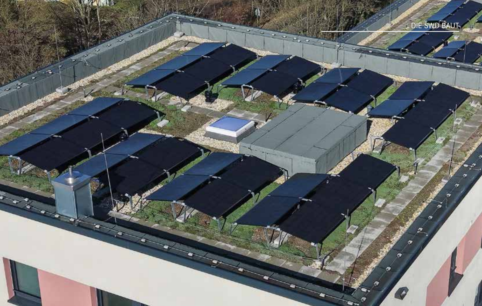
Photovoltaik und begrünte Dachbereiche
