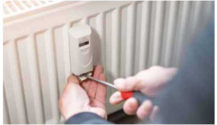
Austausch von Messeinrichtungen
